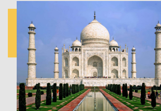
Taj Mahal Commercial Building Project: Parking Guidance System مبنى تاج محل التجاري أسم المشروع: النظام الذكي الارشادي للمواقف
