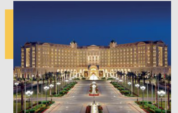
Ritz Carlton Project: Physical Security System فندق ريتز كالتون أسم المشروع: أنظمة حماية أمنية
