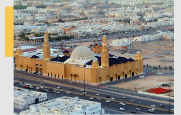
Al-Rajhi Mosque Project: Parking Guidance System مسجد الراجحي أسم المشروع: النظام الذكي الارشادي للمواقف
